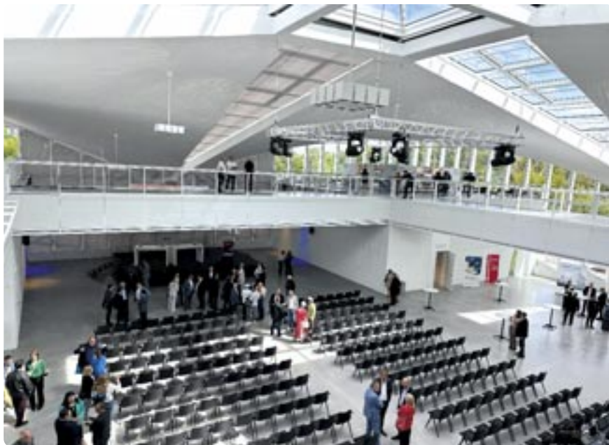
Ein Blick in die wiederhergestellte Hyparschale Foto: Lutz Fiebig
